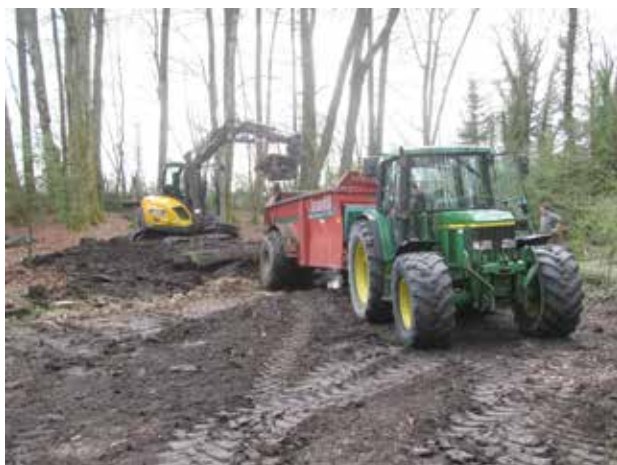
Mit schweren Maschinen wird der Weiherschlamm abgetragen und entsorgt.
