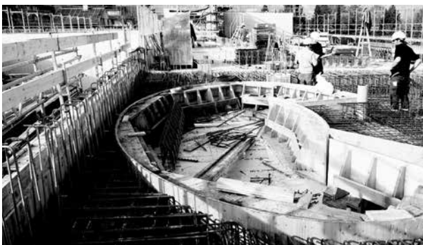
Holzschalung zum Betonieren der ovalen Haupttreppe im Schulgebäude
