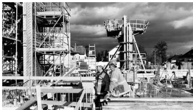
Erstellung der Betonwand als Trennung Klassenraum und Haupteingang Schule
