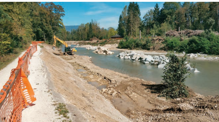
Ein neues Ufer entsteht. Dazu wird zuerst das Flussbett verbreitert.
