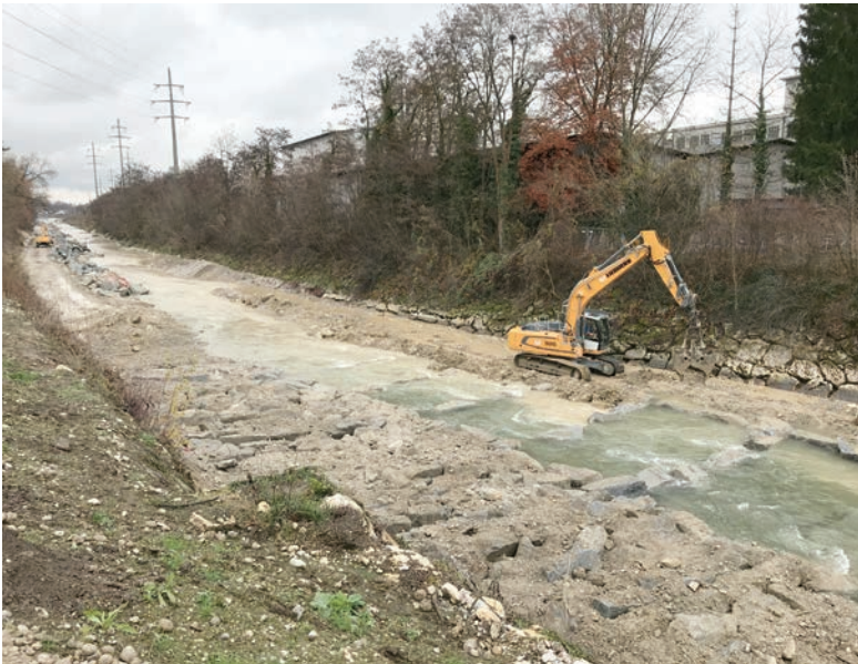
Unterhalb der BLS-Brücke in Biberist wird eine Blocksteinrampe angelegt.
