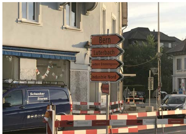
Fotos: Impressionen der Grossbaustelle
