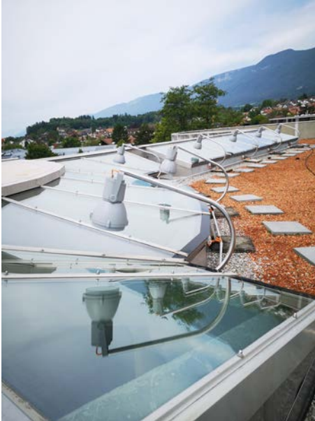
Fensterreinigung katholische Kirche in Langendorf
