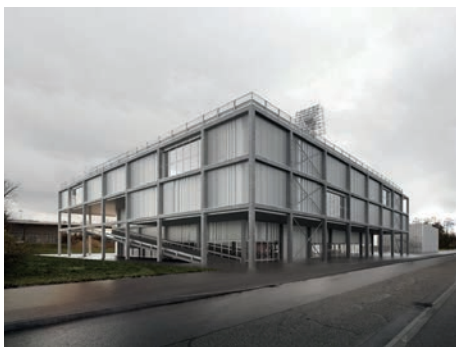
Ansicht Nord-Ost: Neubau der Technikwelt ENTER.
