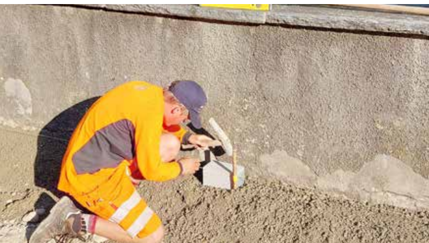
Maurerarbeiten ausgeführt von Cyrill Zuber
