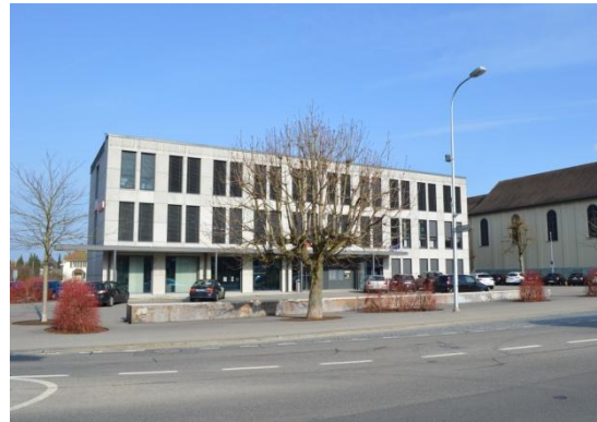
Hauptstrasse 37 und 39 Raiffeisenbank
