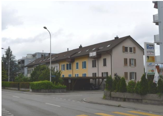
Hauptstrasse 9; Gartenstrasse 1 - 5 Reiheneinfamilienhäuser in Zeilenbauweise
